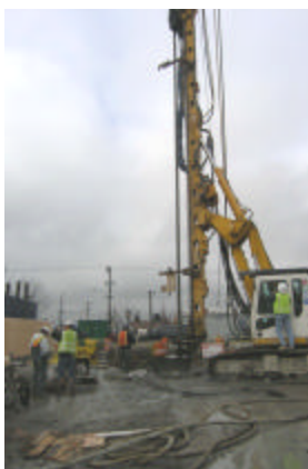
Jet grouting at El Centro de la Raza
