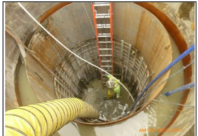
Prepping shaft for transition pour
