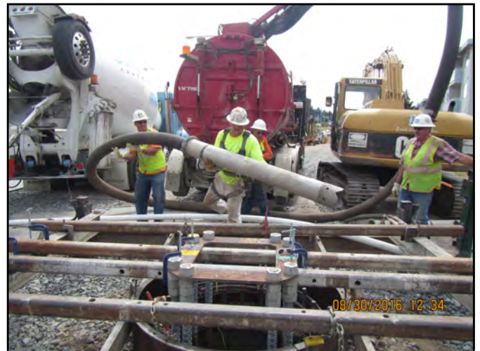
Foundation concrete pour of Pole 2.
