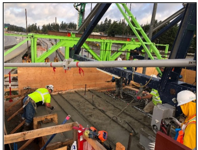
CIP Segment Pour / Traveler Work
