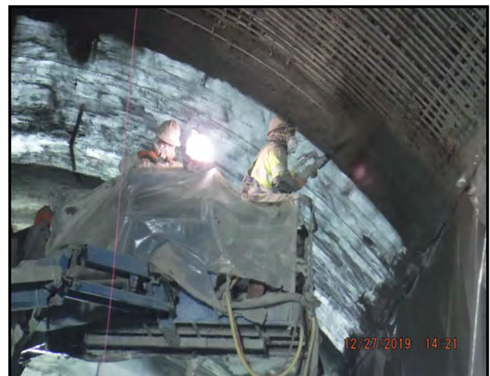
Final Line Pour at the Expanded Zone.
