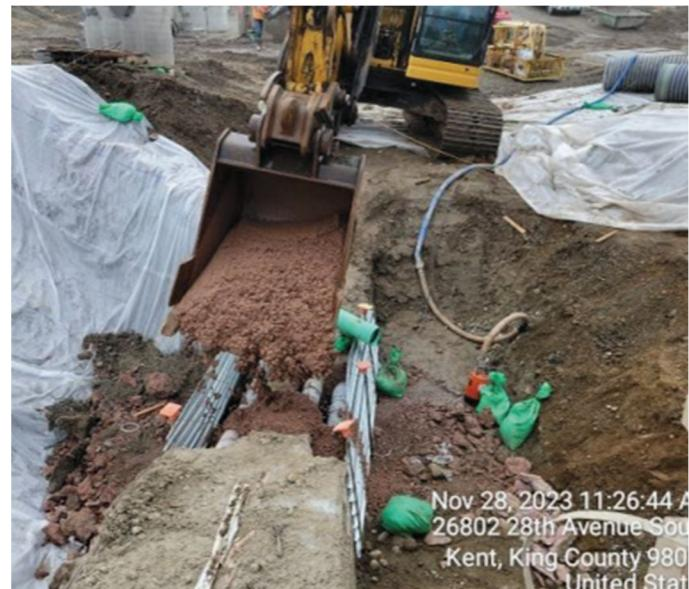
Backfilling TPSS S05 Conduit in Kent
