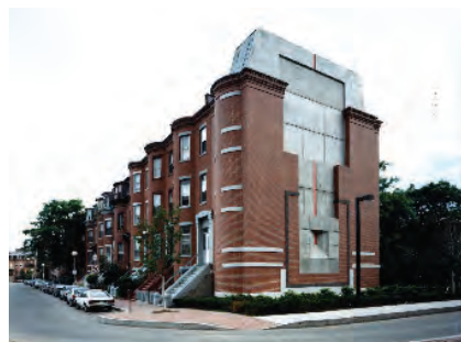
Ví dụ này ở Boston minh họa cho một ví dụ về việc tích hợp hệ thống thông gió với tòa nhà lịch sử
