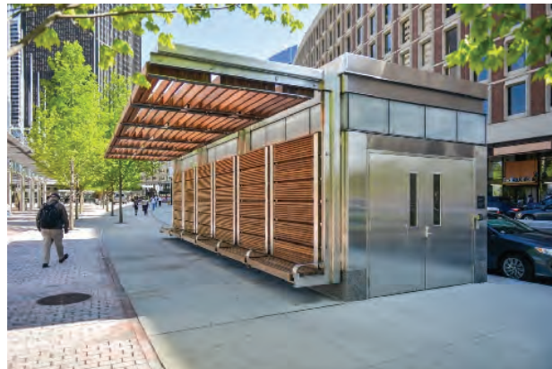
Kết hợp ghế dài và biện pháp bảo vệ thời tiết tại cầu thang thoát hiểm khẩn cấp của trạm tại Boston
