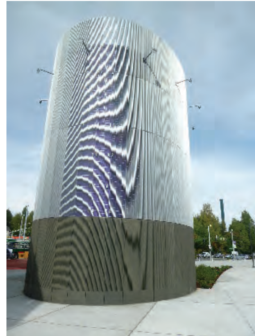
Hệ thống thông gió theo chiều dọc tại Trạm UW ở Seattle
