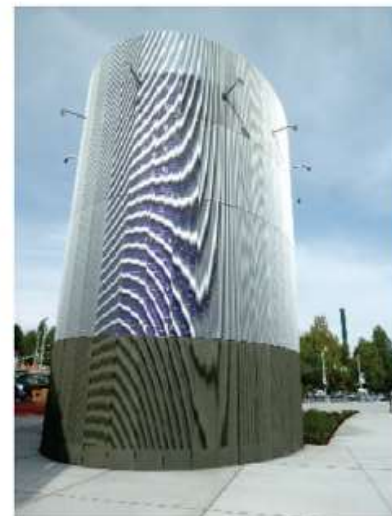
位於西雅圖UW車站的垂直通風口 Vertical ventilation at UW Station in Seattle
