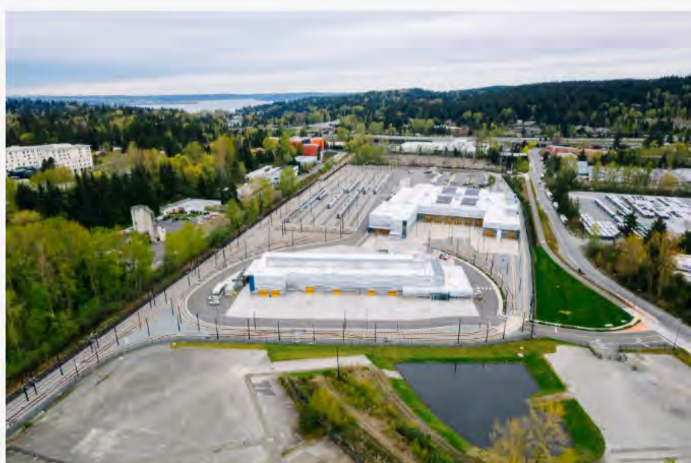
Sound Transit недавно закончил OMF East в Bellevue, который состоит из 28 акров и обеспечивает пути для хранения вагонов наземного метрополитена и практически 180,000 квадратных футов различных мастерских по техническому обслуживанию и другого вспомогательного оборудования. | Кликните на изображение, чтобы увеличить
