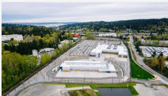
Sound Transit이 최근 공사를 완료한 벨뷰의 28에이커짜리 OMF East 부동산. 경전철 차량 보관 선로, 그리고 다양한 유지 보수가 요구되는 가계 및 지원 시설 180,000 평방피트(square feet)를 보여줍니다. | 확대하려면 이미지를 클릭하세요
