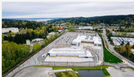
La unidad OMF Este, en Bellevue, recientemente terminada, es una propiedad de Sound Transit de 28 acres. Muestra una bodega con rieles para almacenar vehículos de tren ligero y casi 180 000 pies cuadrados, con varios talleres de mantenimiento requeridos y otras instalaciones de apoyo. | Haga clic sobre la imagen para ampliarla
