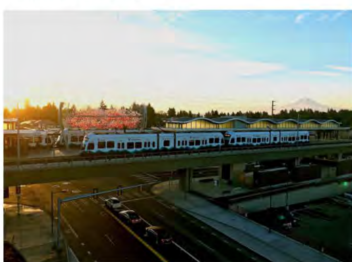
Поезд отправляется по возвышенным путям от станции Angle Lake. Возвышенные пути позволяют людям продолжать ездить на велосипедах, ходя пешком и возить машину внизу.
