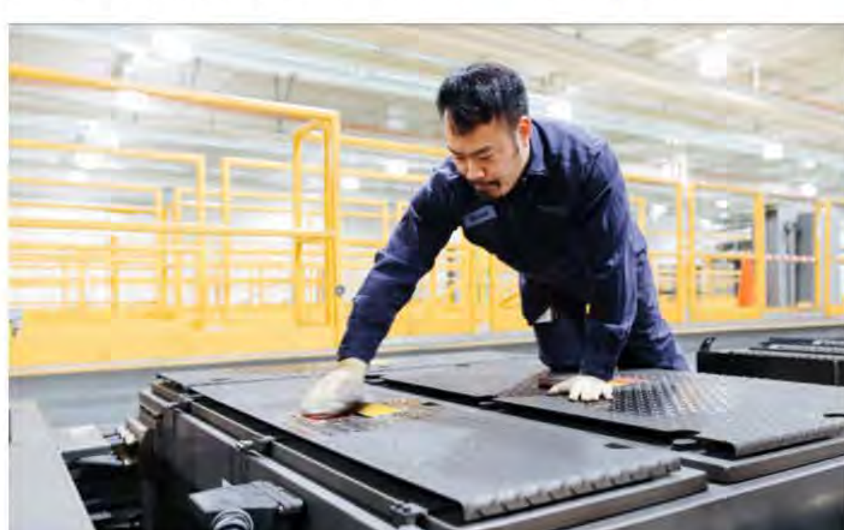
Operations and Maintenance Facility предоставит новые работы и возможности экономического роста на севере Snohomish County.
