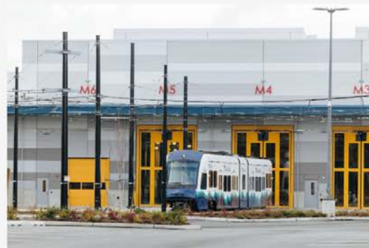
Un vagón de tren ligero está en las vías/rieles de la bodega de vehículos para prepararse para su mantenimiento en la unidad OMF Este. | Haga clic en la imagen para ampliarla
