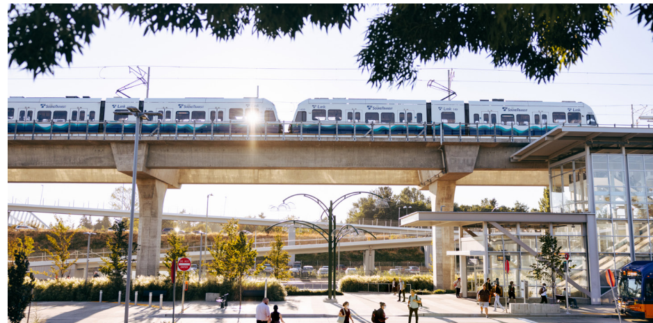
Đường dẫn trên cao (hướng tuyến đường sắt) tại Trạm Northgate. Sound Transit 2022.
