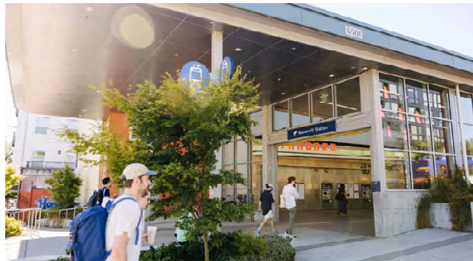
Lối vào trạm
