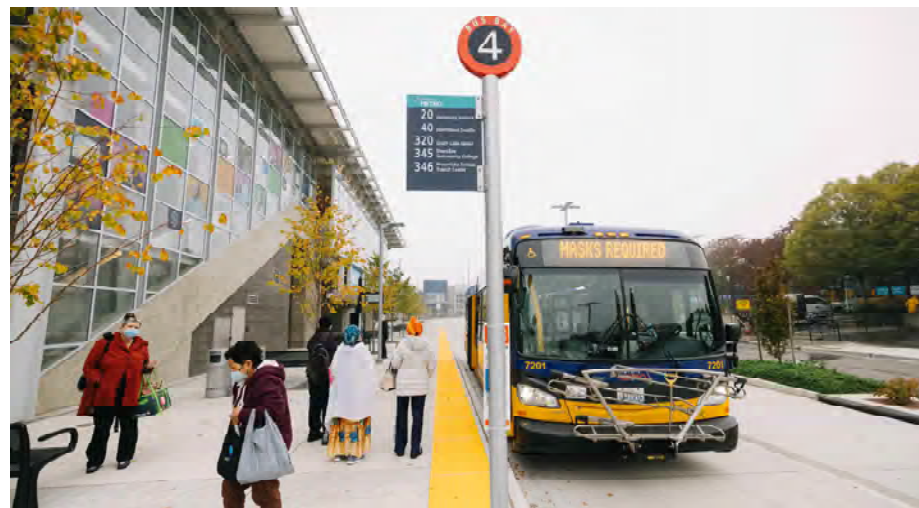
Công trình kết nối trạm
