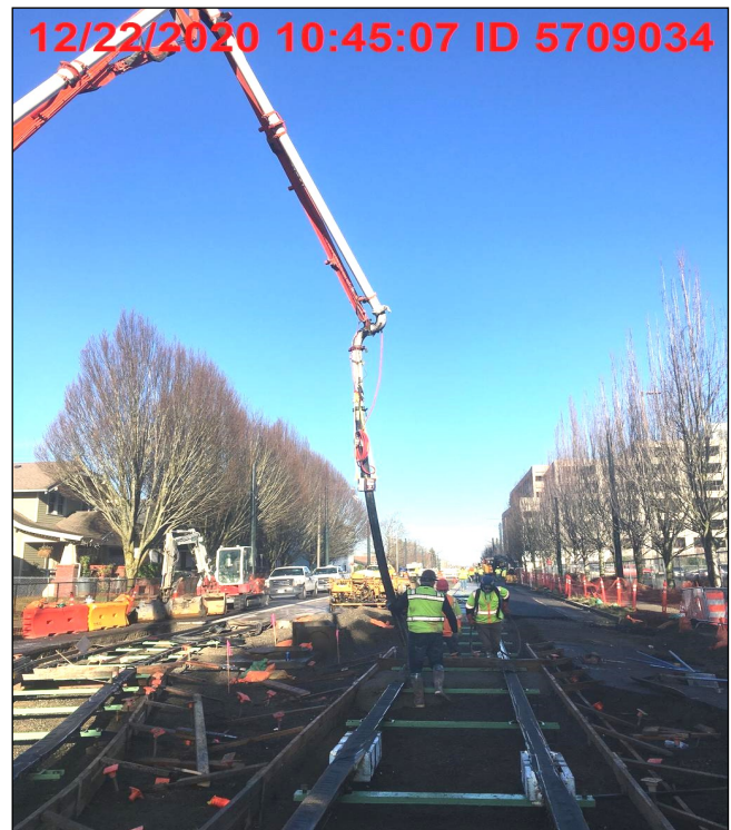
Heading 3— pouring trackslab
