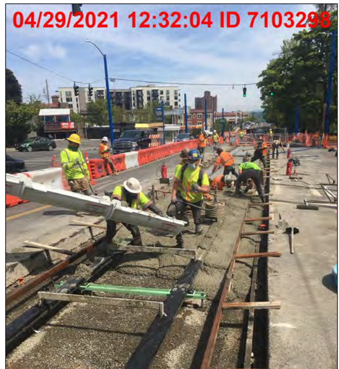
Pouring track slab
