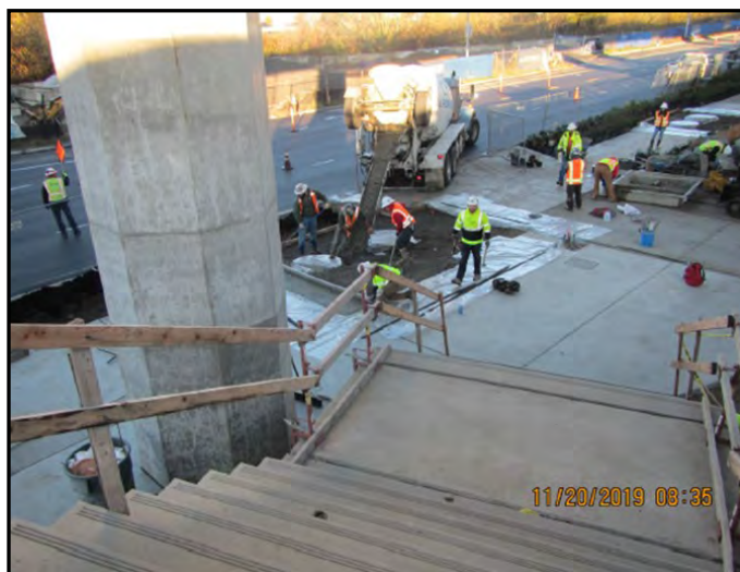
Sidewalk pour east of 1st Avenue.
