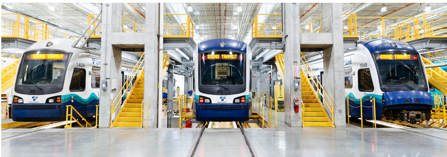
Поезда Link light rail паркуются на площадках для обслуживания в здании обслуживания Link.
