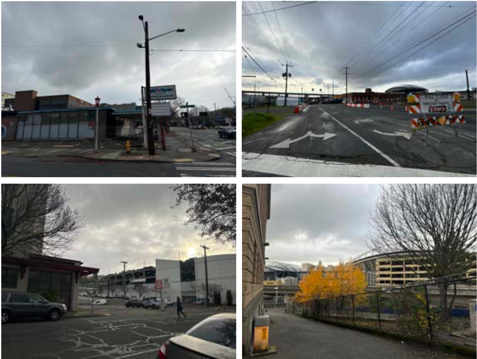
图2.01. 步行审计照片。四张照片拍摄于2023年12月8日的步行审计期间。从左上角开始顺时针排列：南迪邦街与南梅纳德大道交叉口的空置建筑、南机场路的南第六大道、位于南迪邦街与查尔斯街之间朝东的南梅纳德大道，位于南西雅图大道的Inscape艺术中心私人车道。
