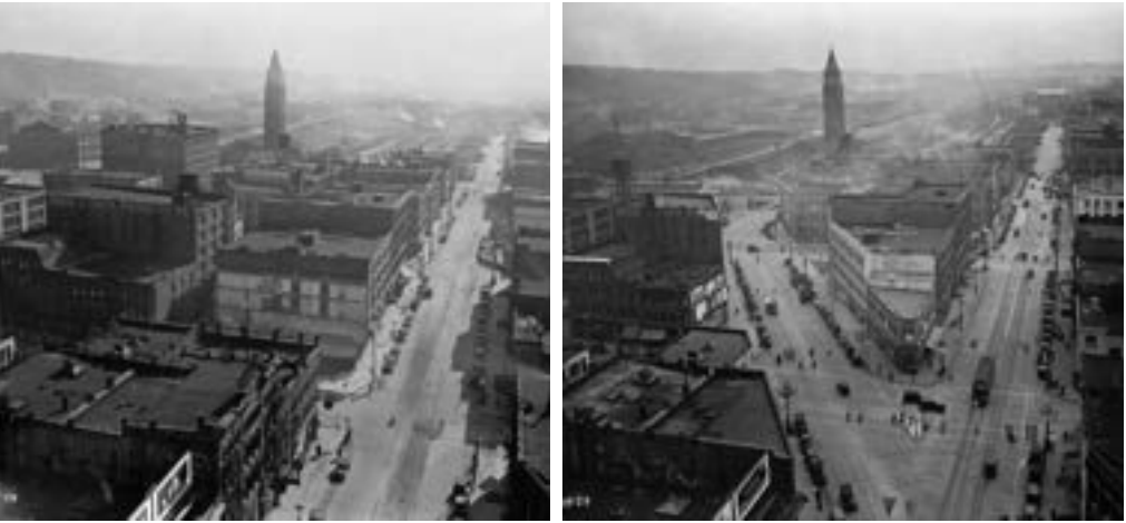
图1.04. 景街站和联合车站。从左到右。顶部：朝北拍摄的联合车站旧照；朝南拍摄的联合车站现状照片。中间：西雅图历史手绘鸟瞰图；景街站现状照片。底部：在修建第二大道南延线之前，从Smith Tower向南眺望；在修建第二大道南延线之后的相同视角。资料来源：西雅图市政档案馆；Nitze-Stagen档案馆；《每日商业日报》(Daily Journal of Commerce)。
