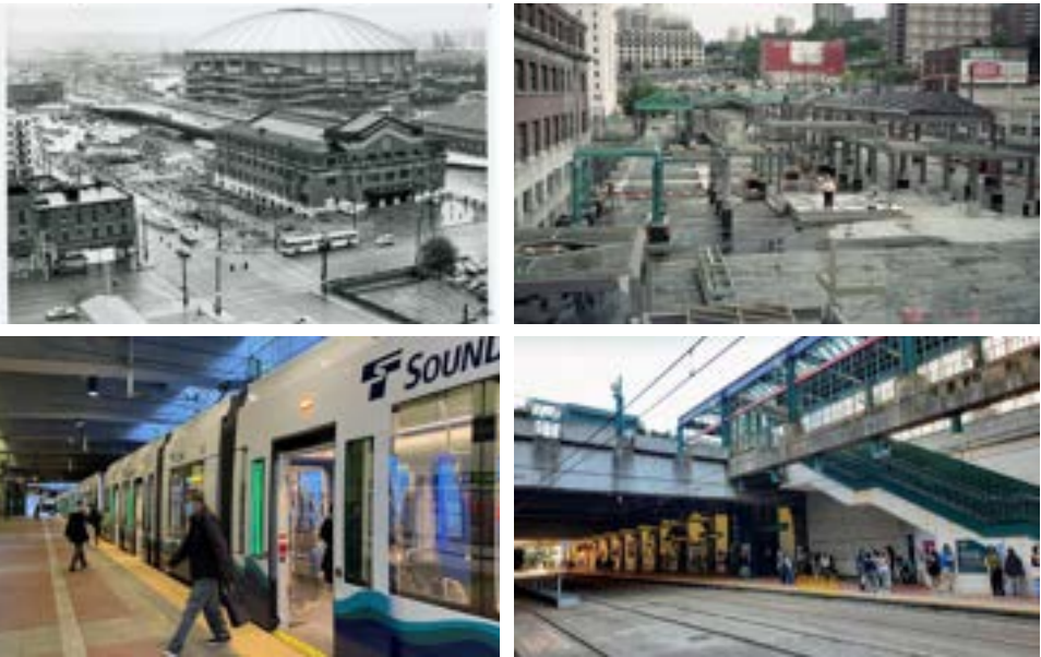
圖1.05. 市中心隧道。上方：兩張照片顯示唐人街/國際區車站廣場與隧道的施工階段。下方：兩張近年交通隧道投入使用的照片。資料來源：Seattle Municipal Archive；Sound Transit。
