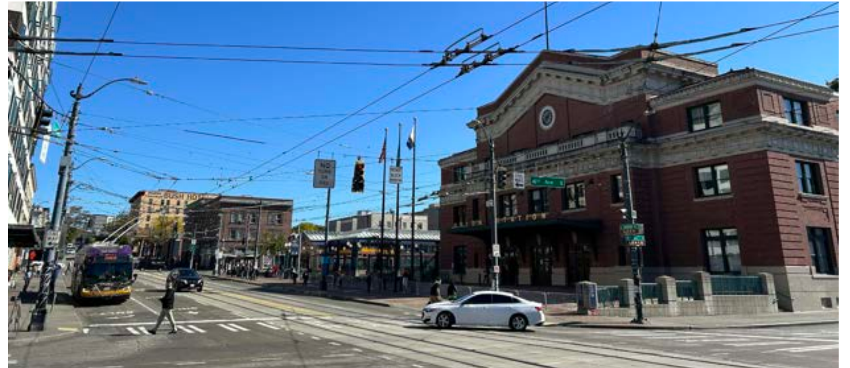
Hình 6.28. Khung Cảnh Hiện Tại của Quảng Trường Phía Bắc Union Station (Nhà Ga Union). Ảnh chụp Union Station (Nhà Ga Union) hiện tại từ S Jackson St (Hướng Nam phố Jackson) và 4th Ave S (Hướng Nam đường số 4), nhìn về phía Đông.
