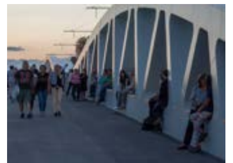
Cầu dành cho người đi bộ bắc qua đường sắt
