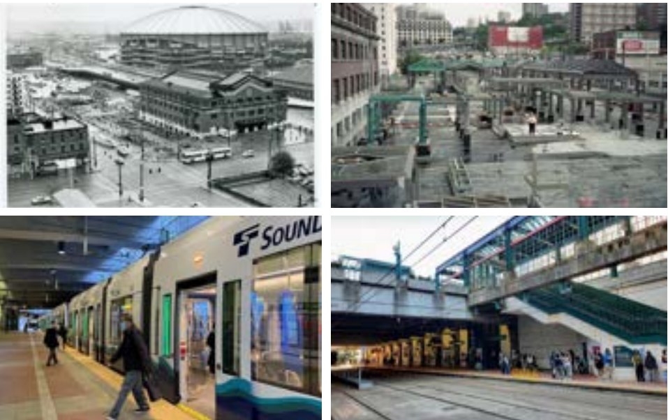
Hình 1.05. Đường Hàm Trung Tâm Thành Phố. Trên: Hai bức ảnh thể hiện giai đoạn thi công quảng trường và đường hầm của Trạm Khu Phố Quốc Tế Chinatown. Dưới: Hai bức ảnh chụp đường hầm giao thông công cộng gần đây đã được đưa vào sử dụng. Nguồn: Kho Lưu Trữ Thành Phố Seattle; Sound Transit.
