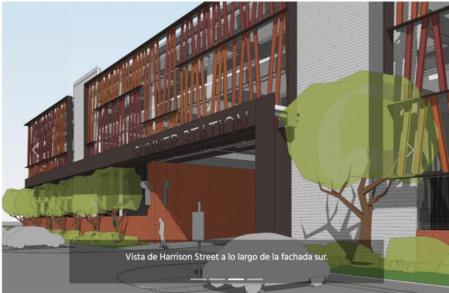
El patrón de diseño abierto que cobija la estructura del estacionamiento está inspirado en los elementos naturales que se encuentran en los bosques del noroeste del Pacífico. La singular rejilla crea intercambios dinámicos de luz y sombra y actúa a la vez como cortavientos y parasol, al tiempo que permite la ventilación natural.
