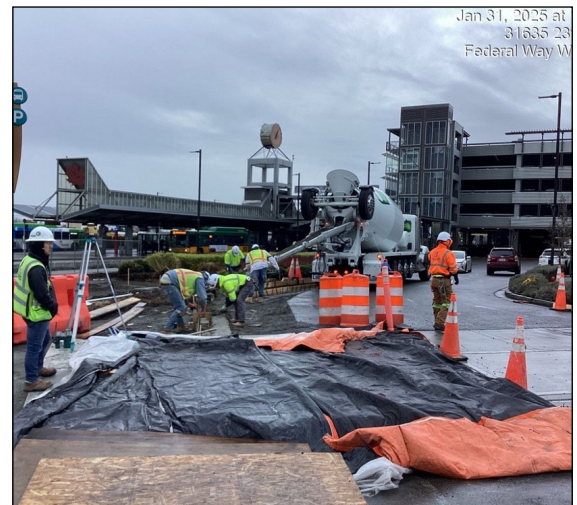
Federal Way Transit Center Driveway Curb Pour
